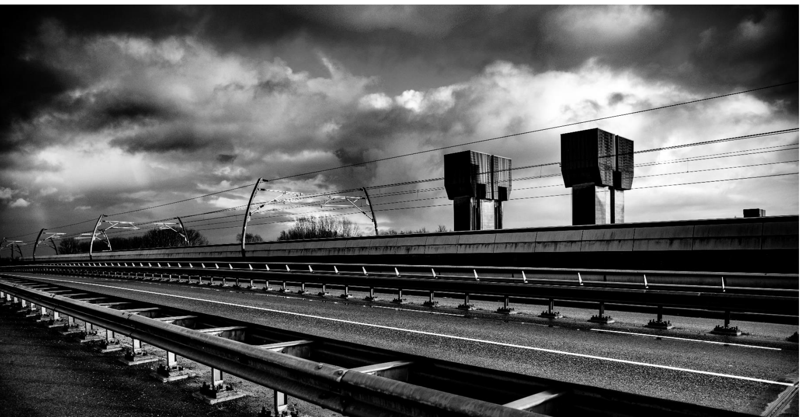
A15, Betuwelijn en Prins Bernardsluizen, bij Tiel.
